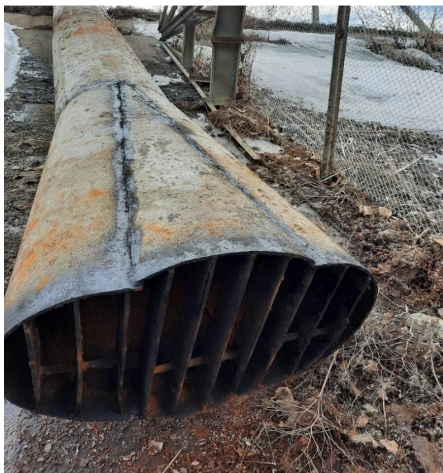
Рисунок 2 - Всасывающий раструб в ходе монтажа
