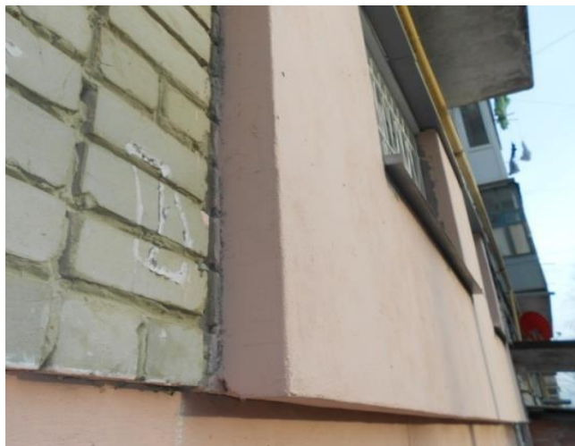
Рисунок 1 – Доступ холодного воздуха в системе теплоизоляции:
